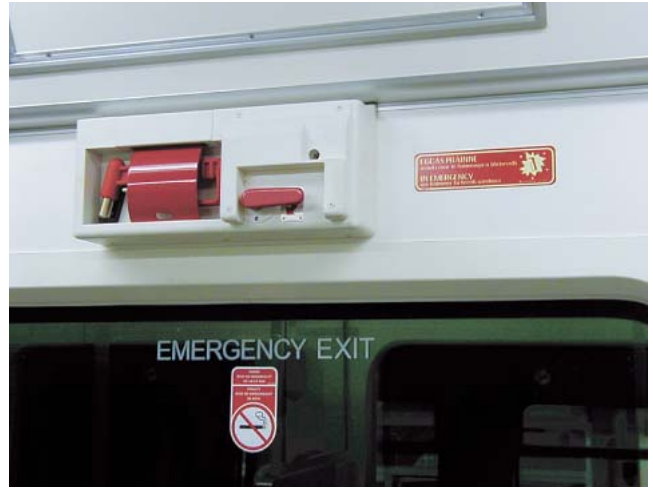
図3 非常ハンマ格納箱
