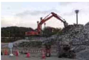
再資源化するコンクリート塊
