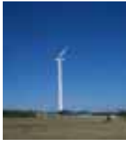
新舞子マリナーパーク 風力発電所 愛知県館で使用
