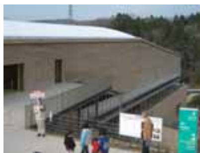
(*2) 2F 部分を学校建設にリユース
