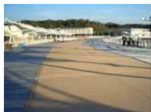
建設中のグローバル・ループ
