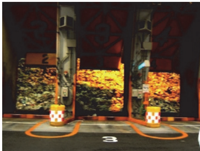
写真：足立工場のごみピット 撮影：津川 敬氏
