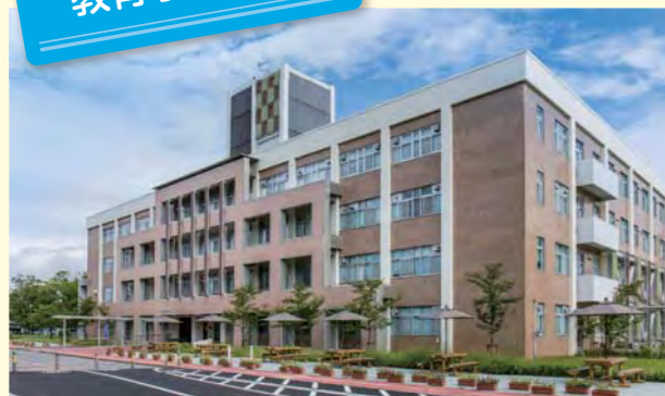
A 専門校舎1号館
