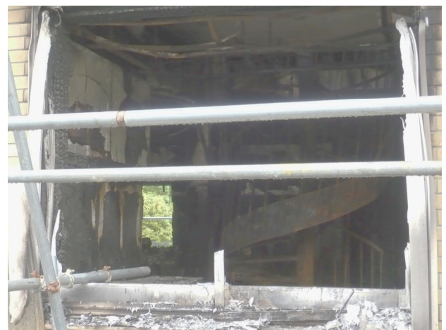
図3 焼損した螺旋階段(7月22日筆者撮影)
