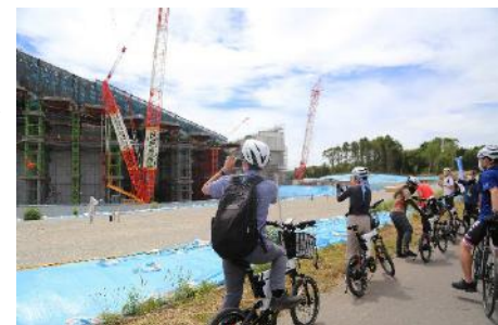
写真1. 建設中のボールパークを見学
