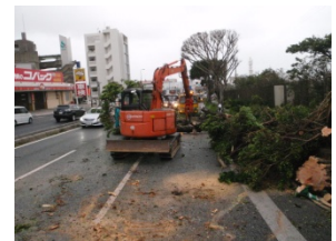
復旧作業 (風倒木処理)
