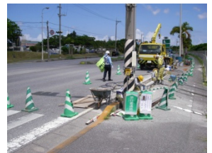
構造物の補修
