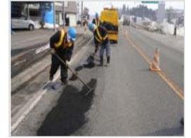
舗装版舗設作業
