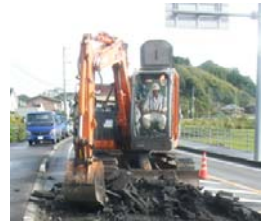
舗装版破碎作業
