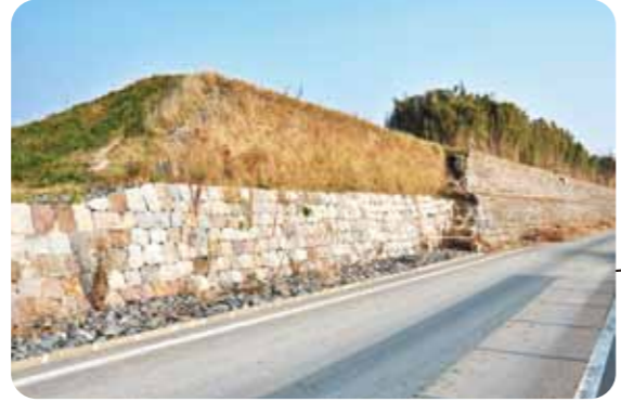
平成20年度に水路工事に伴い堤防の一部が掘削され、断面が調査された。内部に古い段階の堤防が内包されているのが判明し、工事後に復元された。
