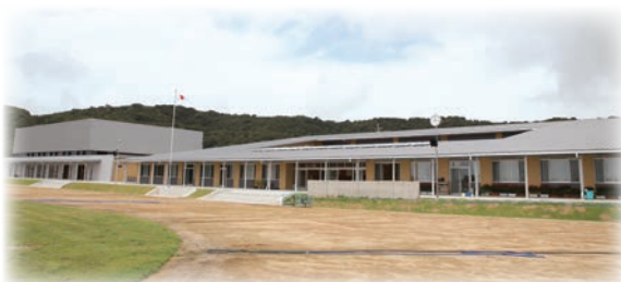
▲完成した新校舎と体育館
