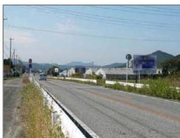
道路の雑草（国道 259 号）
