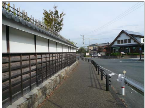
築地塀風の公園外構
