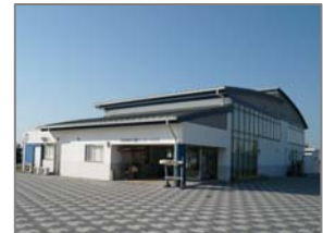
白谷海浜公園 センターハウス
