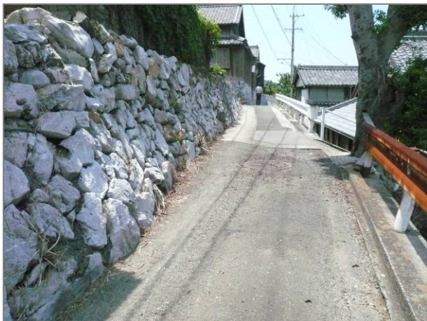
石灰岩の石積み
