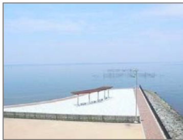
修景デザインに配慮した港の施設
