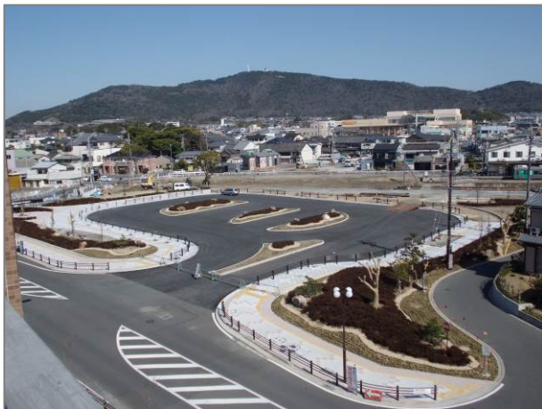
整備中の駅前広場
