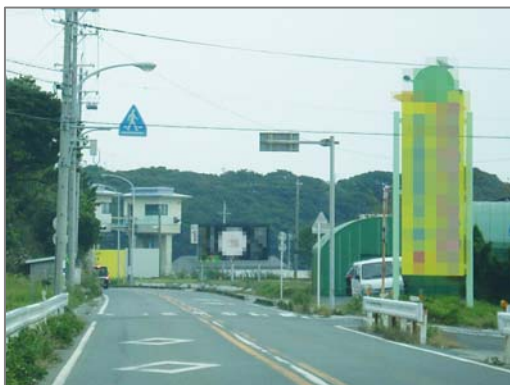
大型の屋外広告物
