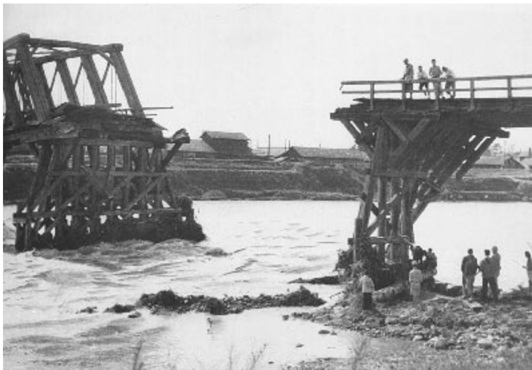
昭和24年の洪水で中央部15㍍を流された東橋
