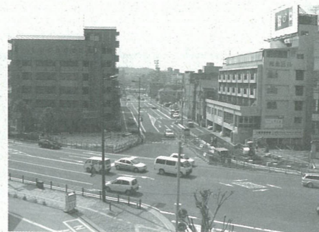
■工事が進む都市計画道路田室町春日線
