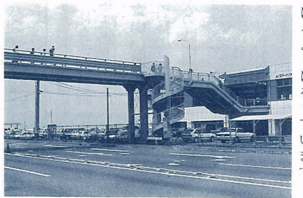
高崎山へ通じる2階からの歩道橋
