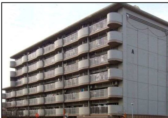
シティファミリー向島（平成8年度建設）
