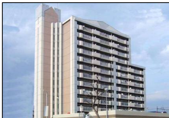
シティファミリー吉良（平成8年度建設）
