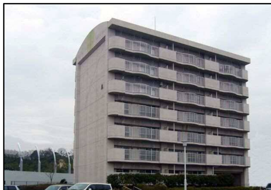
シティファミリー小坂（平成6年度建設）
