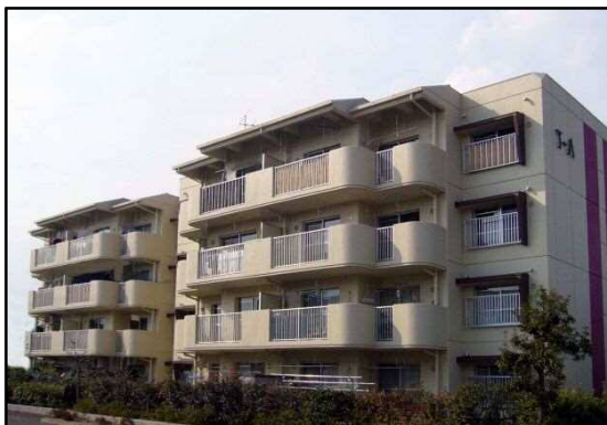
港北南荘（平成2年度建設）
