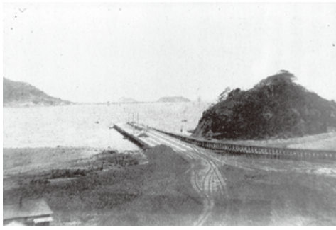
今はない蛇島を利用して造られたイトツケレップの木造仮橋 ここから石炭を積み出した
