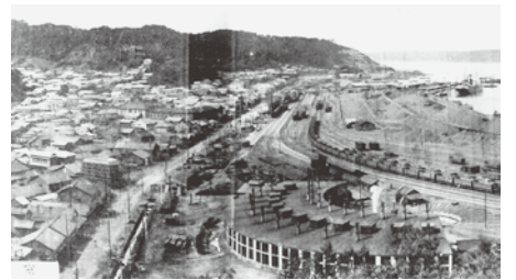
北海道内では初の鉄筋コンクリート造りの扇形機関庫。SLは止まっている間も冷えないように釜だきを続けるため、周辺では、煙、騒音、振動が絶えなかったという。 (現在の長崎屋中央店前付近)
