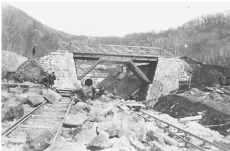
岩盤質の山を掘削し、難航した仏坂のトンネル工事
