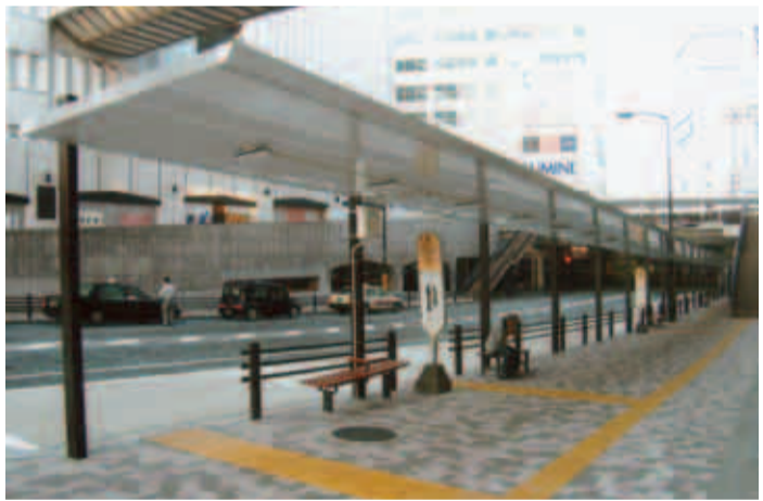
原町田大通り(都市計画道路3・4・11号線)沿いの町田東急ツインズWEST前のバス停に屋根が設置されました。屋根は幅2.4m、長さ約59mです。 ☎都市計画課709・0614 FAX709・0598
