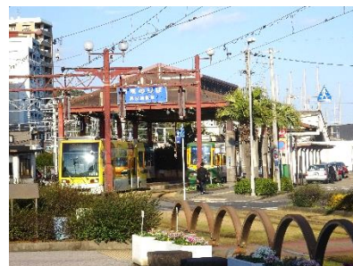
JR 鹿児島駅 (建設中)・市電乗り場
