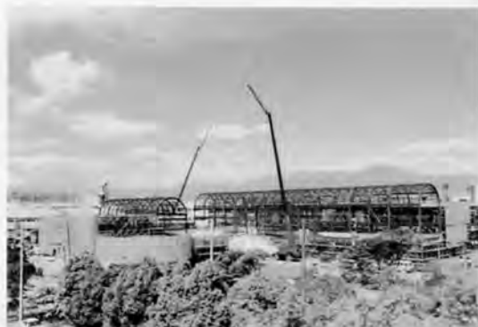
建設中の美術館
