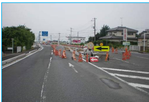
国道 122 号(4車線化整備中)
