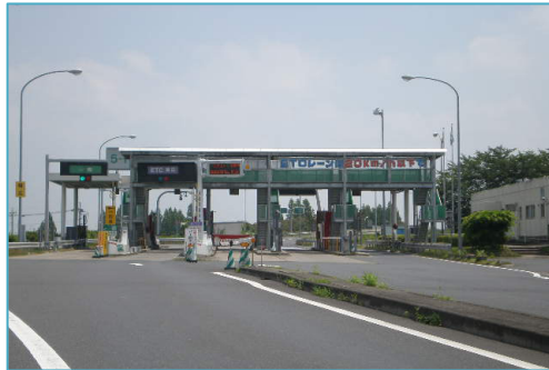
羽生インターチェンジ
