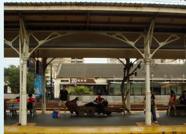
第二月台 → 基礎拆除仿作， 棚架拆卸與回組
