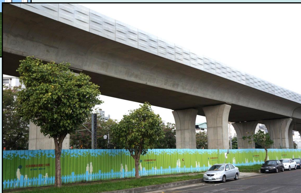
▲ 站區漸變段橋梁完工照片
