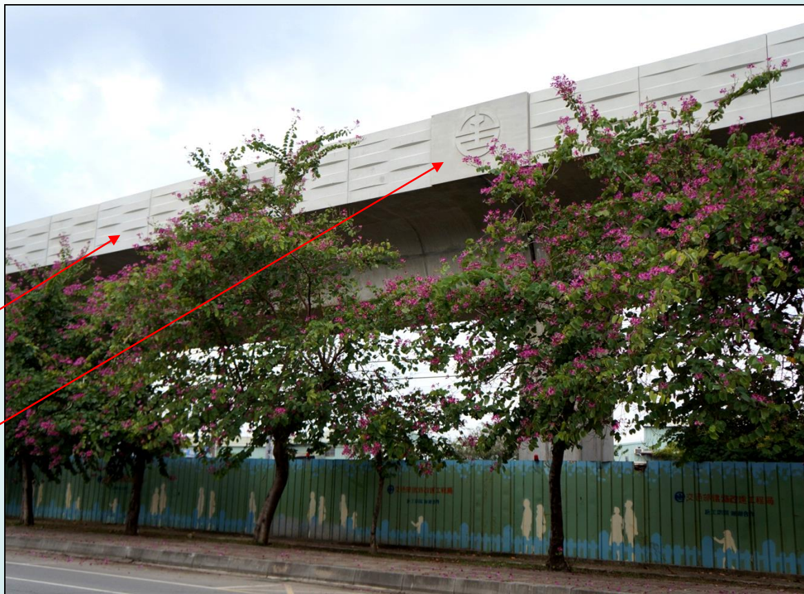
▲護欄完工照片
