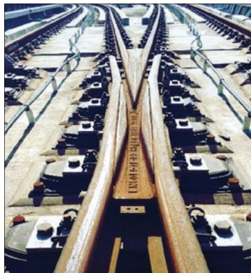
圖 9 整體鋁鋼岔心
