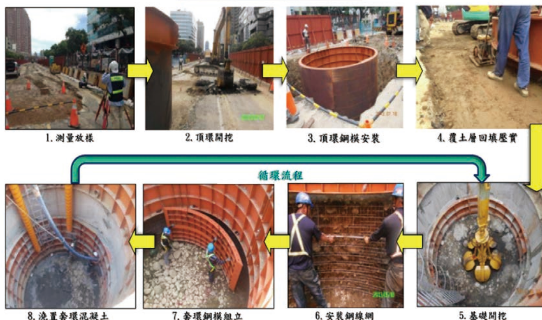
圖 14 井基施作流程
