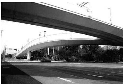
外堀通の交差点。高速道路が上を覆っている
