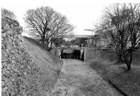
名古屋城外堀跡。奥に御園橋が見える。 そのむこうの地下をシールドが通っている
