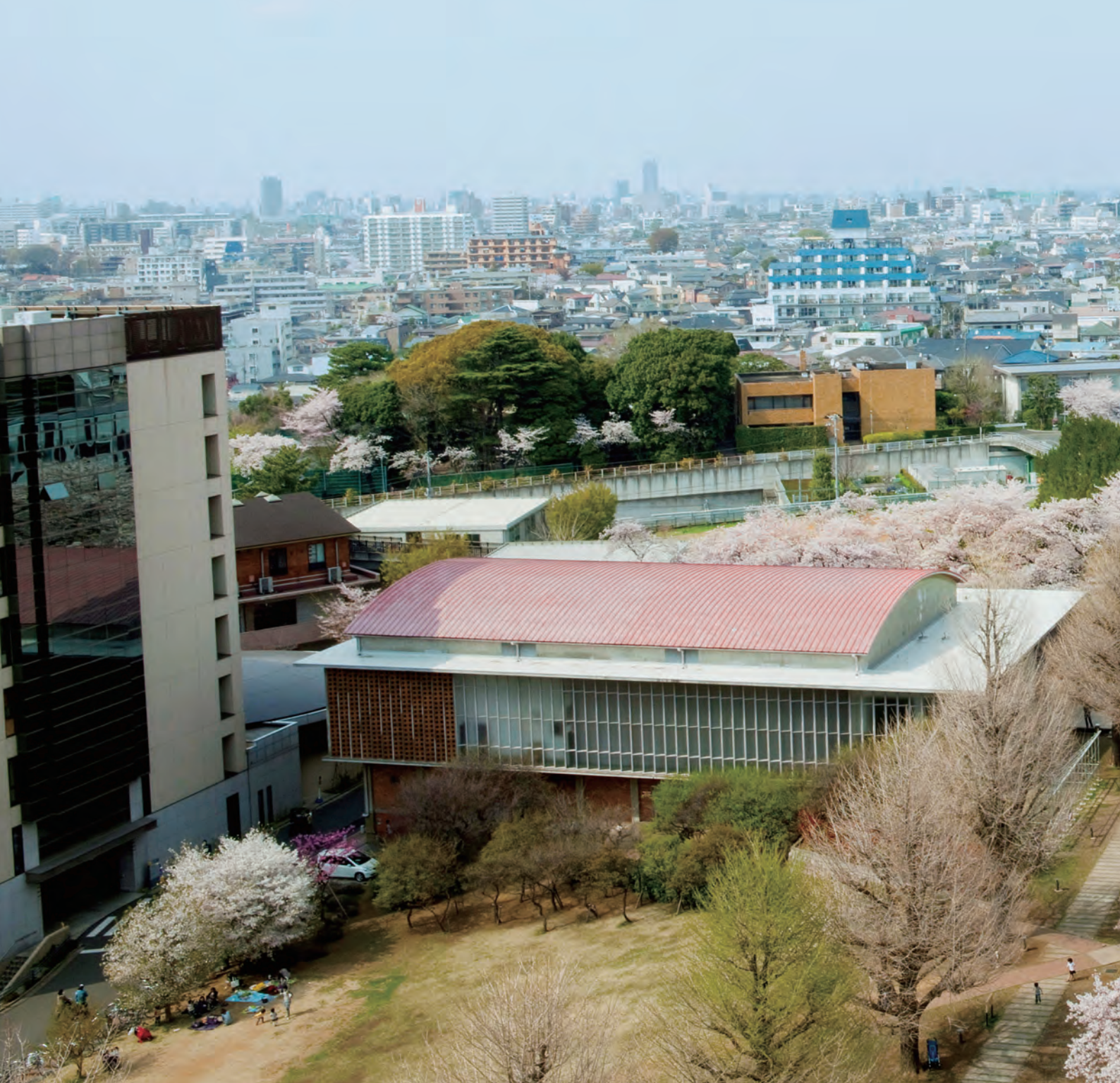
大岡山西9号館 Ookayama West 9 Building
