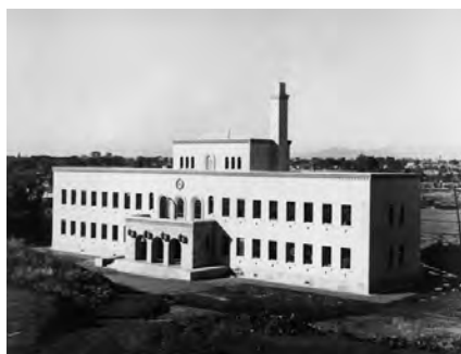
分析化学教室 (1931年9月竣工)
