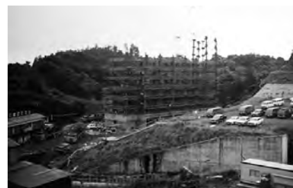
建設中の総合理工学研究科棟1号館（1977年竣工）
