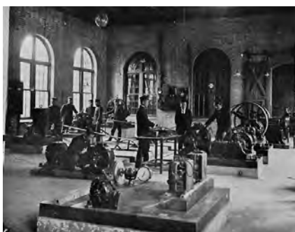
電気科電気機械分科発電室 (25年史より)
