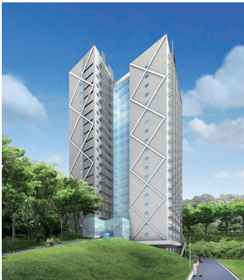
すずかけ台キャンパス J2 棟と J3 棟 (J3 棟は建設中) Suzukakedai Campus J2 and J3 (in progress) Buildings
