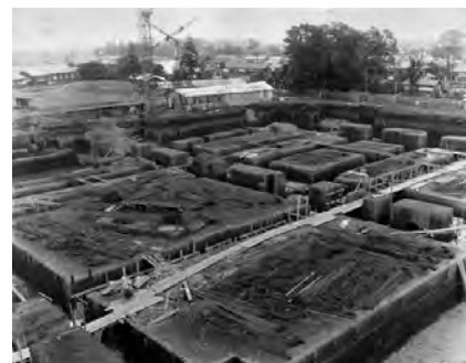
本館基礎工事(1931年)
