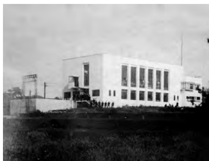
水力実験室 (1932年8月竣工)
