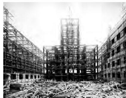
本館鉄骨 (1932年7月13日、新営工事アルバムより)
