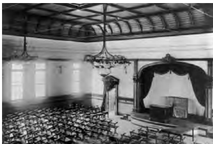
東京高等工業学校講堂の内部
