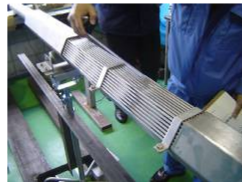
ラッパ管引抜き状況
