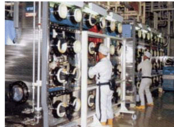
グローブボックス設備
