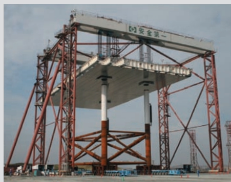
上部・下部ジャケット一体化
