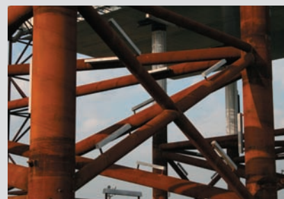
柱の部分に防食用アルミニウム合金製の陽極がたくさん付いているのがわかる
