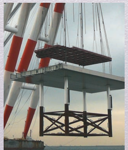
ジャケット掘付状況 写真) 羽田再拡張D滑走路建設工事共同企業体
