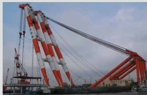
ジャケット据付
