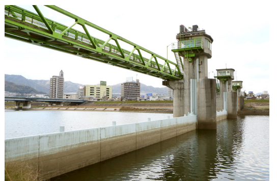
上流左岸から見る祇園水門
