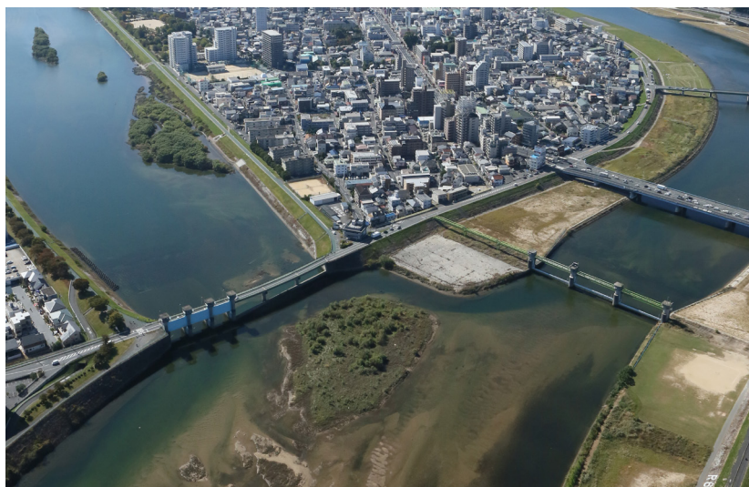
太田川放水路の要「大芝水門と祇園水門」（平成27年） 太田川から市内派川への分岐となる大芝水門（左）、放水路への分岐祇園水門（右）から下流を望む。
