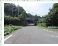
2 近鉄線の高架をくぐる道
