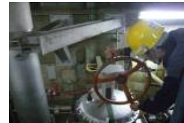
(写真は主蒸気逃がし弁模擬操作訓練の様子)
