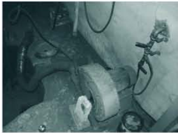
사진 19 송풍기의 설치 상황
