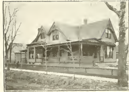
Residence of A. H. Doune
