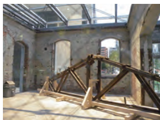
旧48番館の内部とガラス屋根
