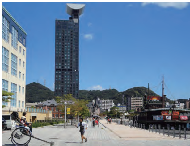
第一船溜まり沿いプロムナードと門司港ホテル、ハイマート
