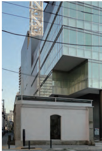
保存改修された旧48番館
