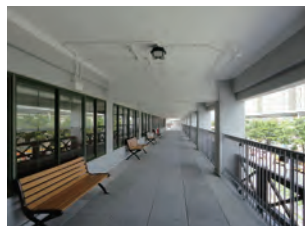
改修された2階屋外通路
