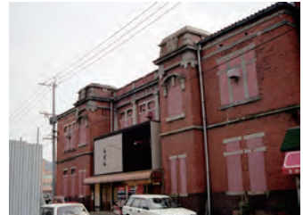
改修前の状況(1980年代)
