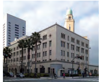
改修後の横浜税関本関庁舎
