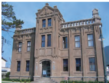
修復された外観
