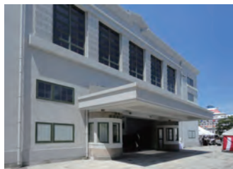
改修された大連航路上屋の東側正面玄関
