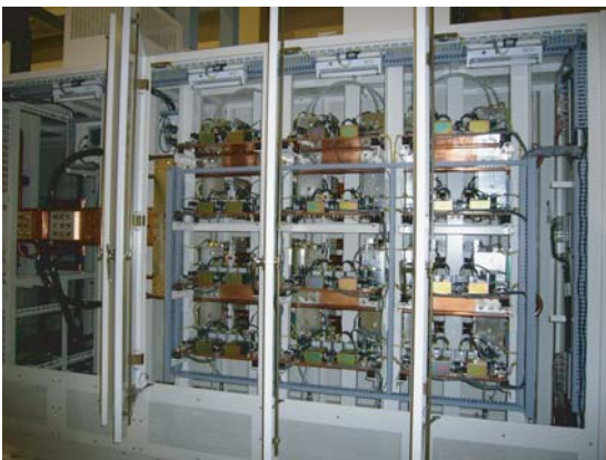
図7 変換器内部構造
