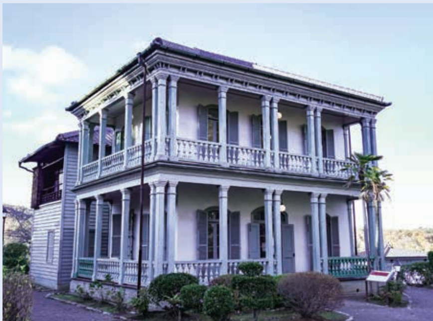
神戸山手西洋人住居のベランダ。列柱が美しい
