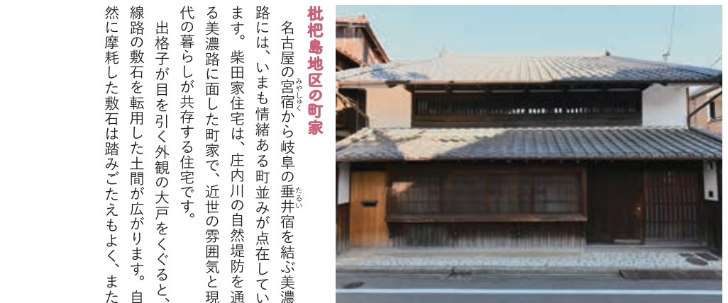
外観をみる。出格子は改修時のもの
