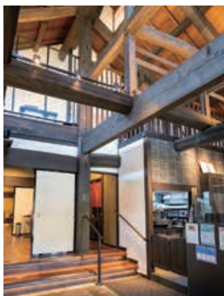
土間を改修したホールと小屋組み
