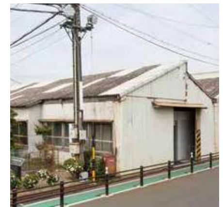
東棟の外観。防火のため亜鉛鉄板が張られている
