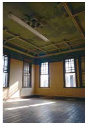
2階洋間。切断された格天井に注目
