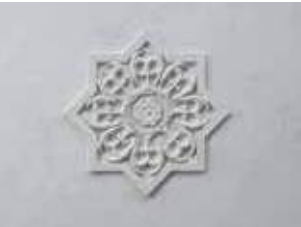
応接室天井の漆喰装飾
