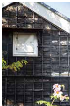
東側の下見板張りの外観
