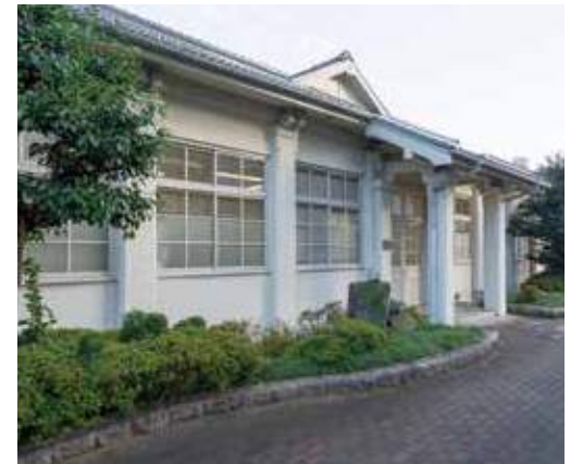
外観。正面の屋根には千鳥破風が載る
