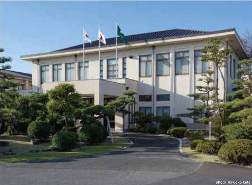
本館の外観。現在はモルタルが吹き付けられスッキリとモダンな印象。よく見ると1、2階を通す柱型が確認できる
