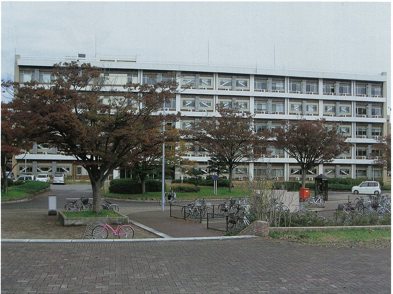
耐震改修工事後の農学部建物正面
