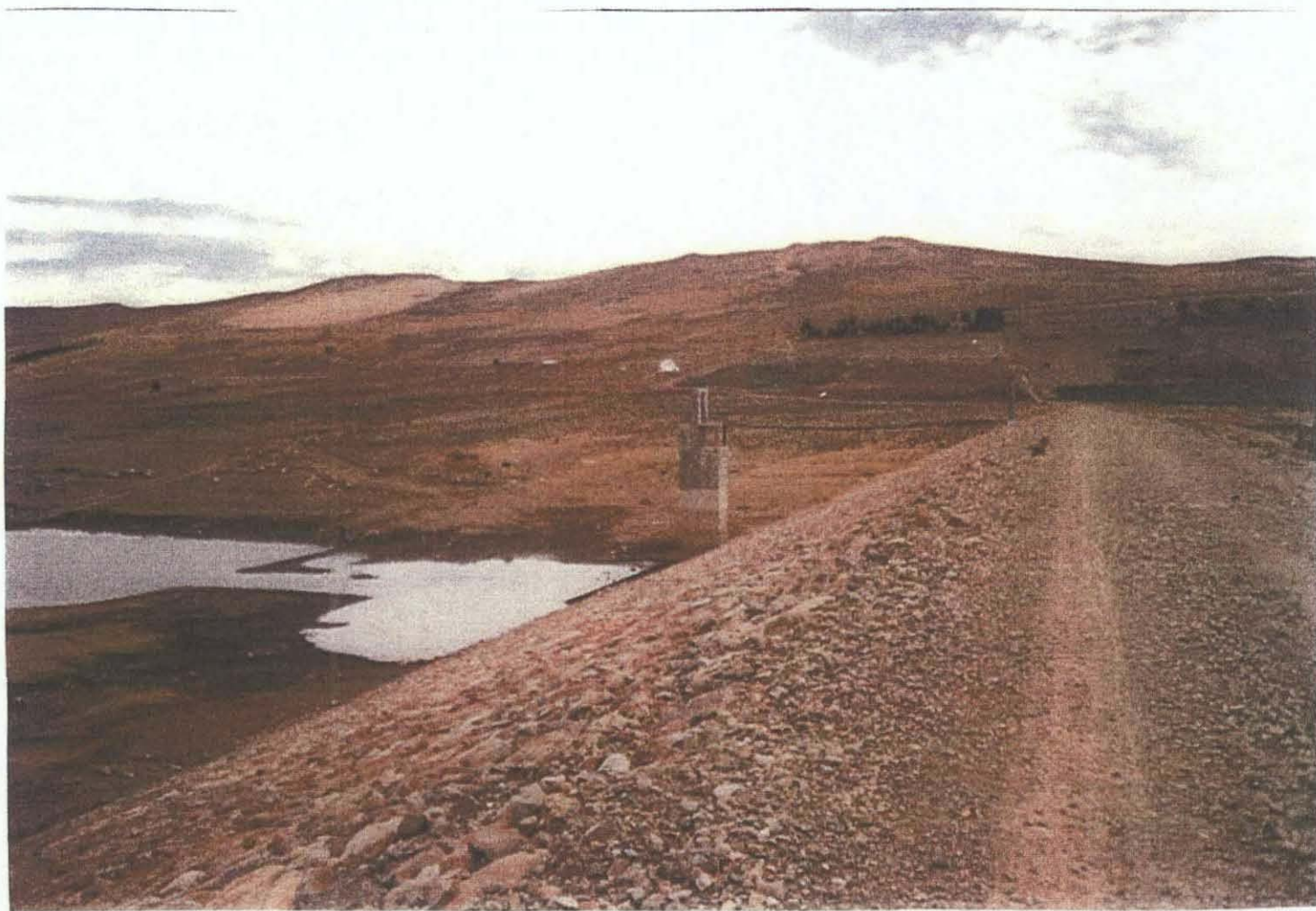
トラ・コッチャダム堤体(ロックフィルダム)
