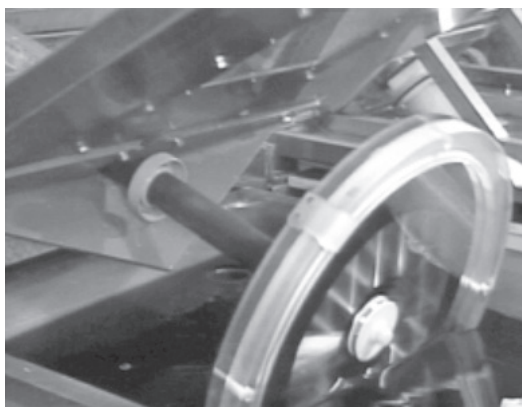
図 4.6 電鍍槽（ニッケルメッキ槽）
