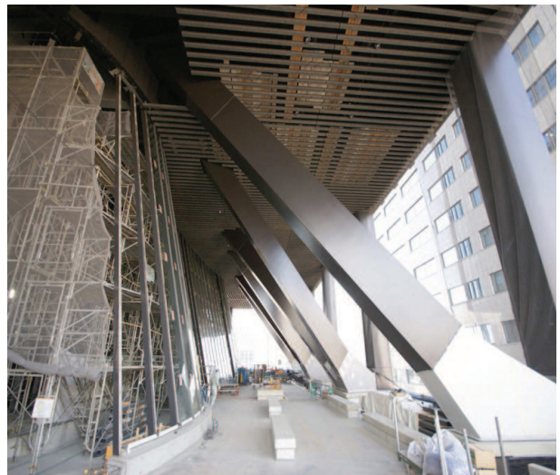
図9 メガトラス工事状況
