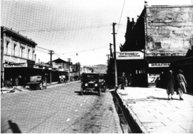
図10 道路から1.5mセットバックしたRoach デパートの仮店舗 (Hastings Library)
