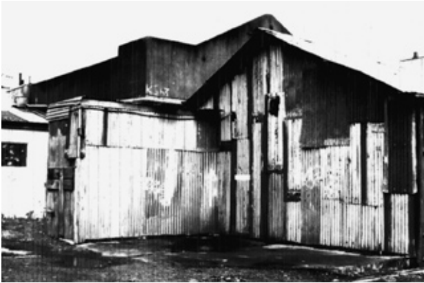
図9 トタン造りの仮店舗 (Hastings Library)
