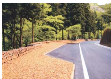
駐車スペースの様子
