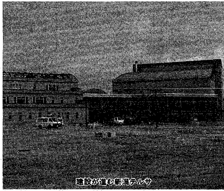
建設が進む新潟テルサ
