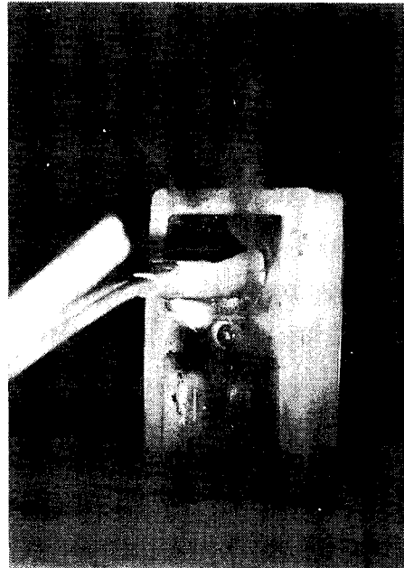
写真1 トラッキングによる発火例
