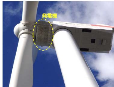
初号機設置、稼働状態 (J100-2.7, J Power 響灘にて)
