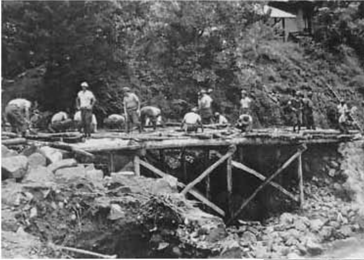
上割南海入口の応急架橋の自衛隊員、真夏の汗だくの復旧作業だった(7月14日)
