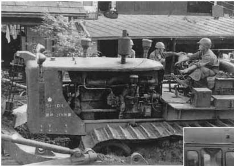
新宮川岸福寿屋前で自衛隊員による復旧活動 大型ブルドーザー
