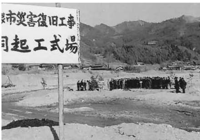
駒ヶ根市三六災害復旧工事の合同起工式を行った。県、市の関係者、建設業者など180名が集まった。新宮川岸地籍
