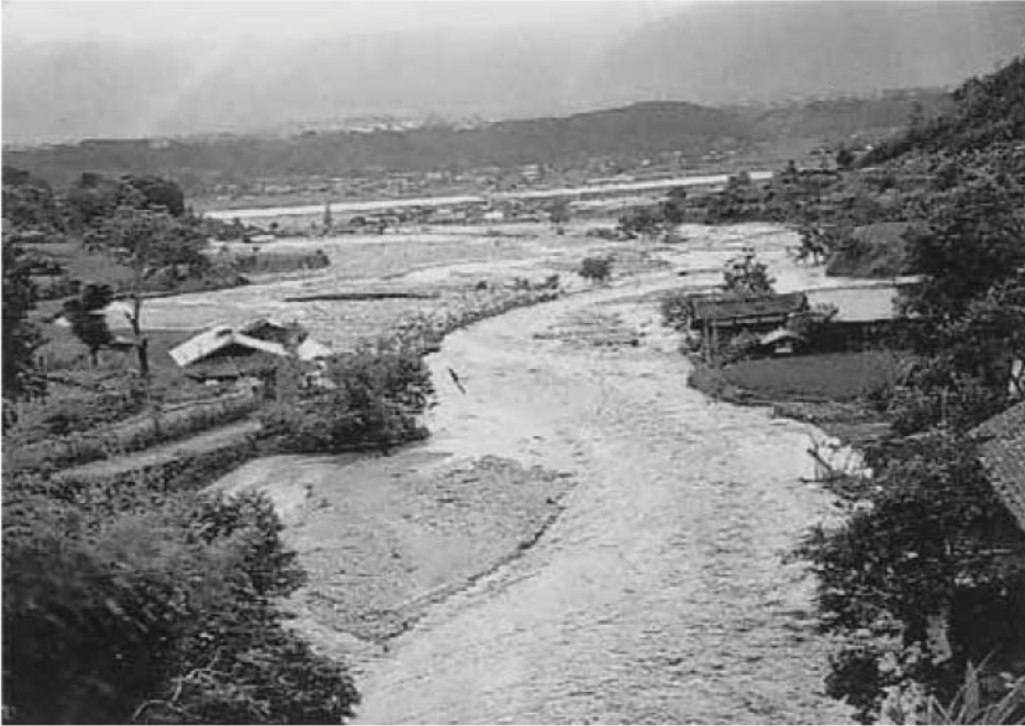
松木平橋の原側より撮影 左岸は■■■■氏宅その左側は冠水した下割の水田、右岸は■■■■氏宅(■■■■)土蔵の元まで土砂が入り込んだ。遠方の白く見える直線は増水の天竜川
