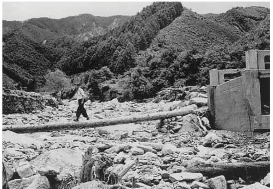
桃ヶ平百々目木川の四徳方面へ架かる橋は36年3月竣工。この橋に流木が詰まって川の流れが変わり下流の耕作地に大きな被害が出た(丸太橋を渡る中沢局の集配人)
