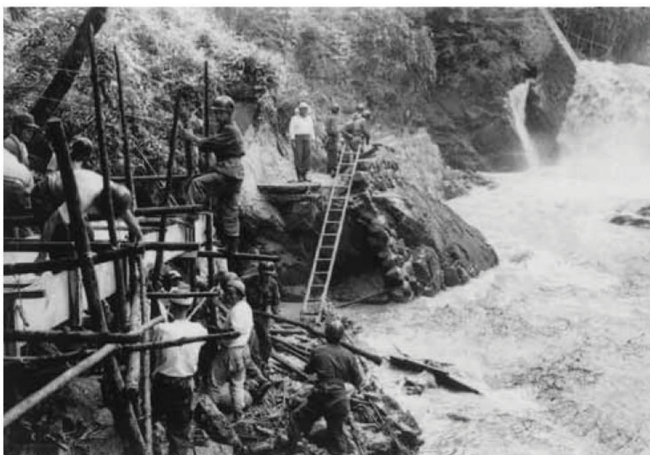
百々目木地籍において水路復旧の難工事に活躍する自衛隊員
