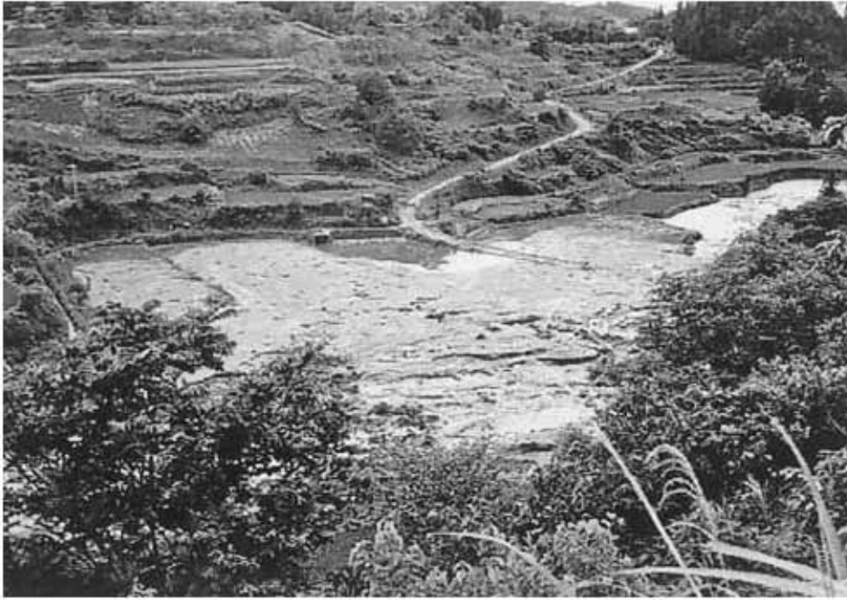
中曾倉から中割に架かる大津渡橋、水田が流失し一面河原となった。新大津渡橋は昭和38年に完成した
