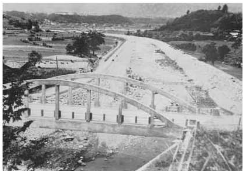
三六災害後に架け替えされた松木平橋と嵩上げされた堤防
