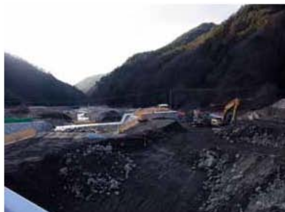
工事中の唐山入口 李平
