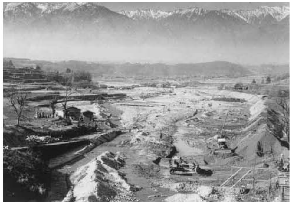
松木平橋付近の堤防建設工事 重機と言えばブルドーザーが活躍した
