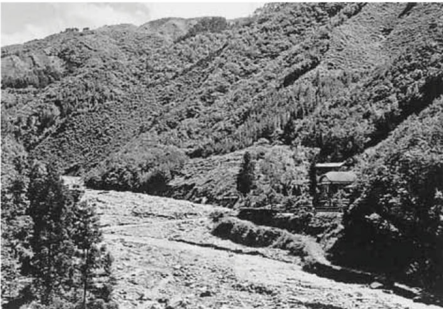
南分校前の百々目木川は40mの川幅となって、校舎も流される危険にあった。
