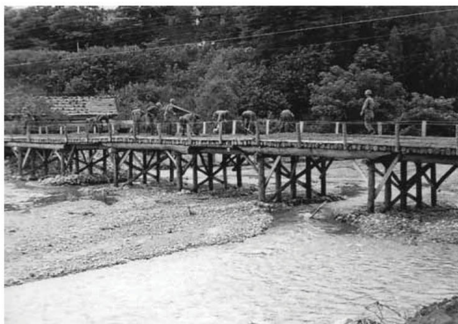
自衛隊員による 102建設大隊施行の仮設新宮川橋が完成した。 渡初式の準備をする自衛隊員
