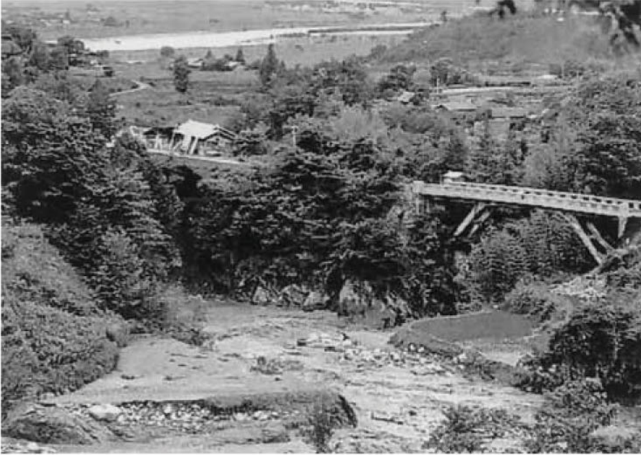
岸壁に架けられた御社宮司橋は安泰だった。僅か上流の■■■■氏宅(■■■■)は流れてしまった
