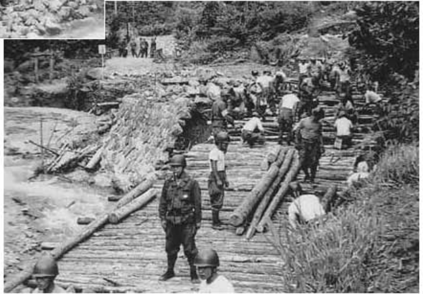
南海橋の仮設橋の建設に当たる自衛隊員
