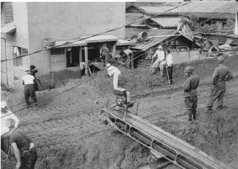
新宮川岸には2mの土砂が堆積した。自衛隊員の皆さんと地元の皆さんはベルトコンベヤーを使って土砂を片付けた(本多写真館前)
