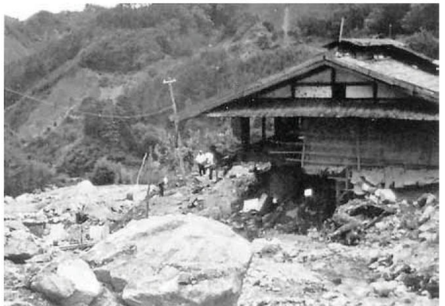
「ナギの沢は岩肌に見える比較的崩れやすい地質である」と伝えられていた。■ ■■■■氏宅(■■■■)の土蔵、納屋が全滅した
