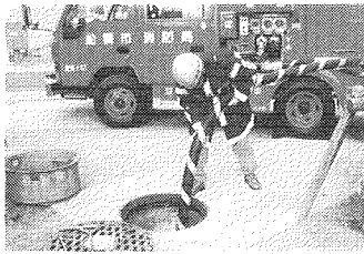
写真-12 マンホール取水 13)
