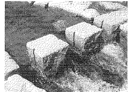
写真-8 セギ板用の切込み
