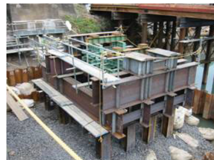
図8 H鋼仮橋脚設置状況
