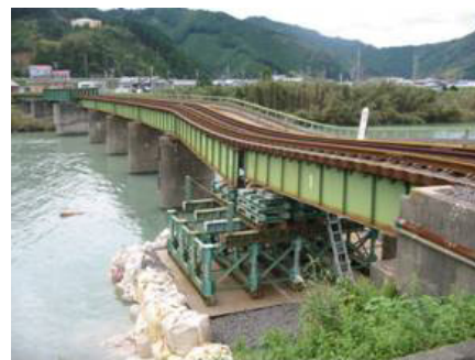
図5 桁仮受状況
