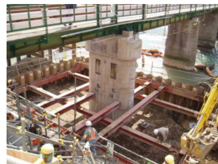
図10 本復旧後の本設橋脚 (平成17年3月1日現在)
