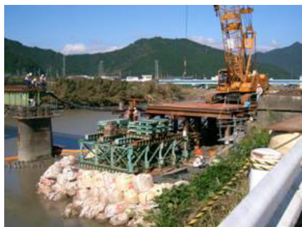
図7 桁の仮撤去後の状況
