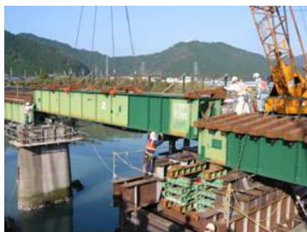
図9 桁復旧状況
