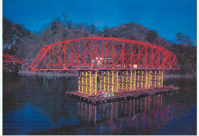
写真-3 ユニフロートによる移設風景（提供：広島県環境生活部）
