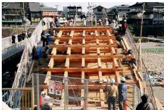
「平成の架替」工事の様子 多くの大工が集まり工事が行われた。
