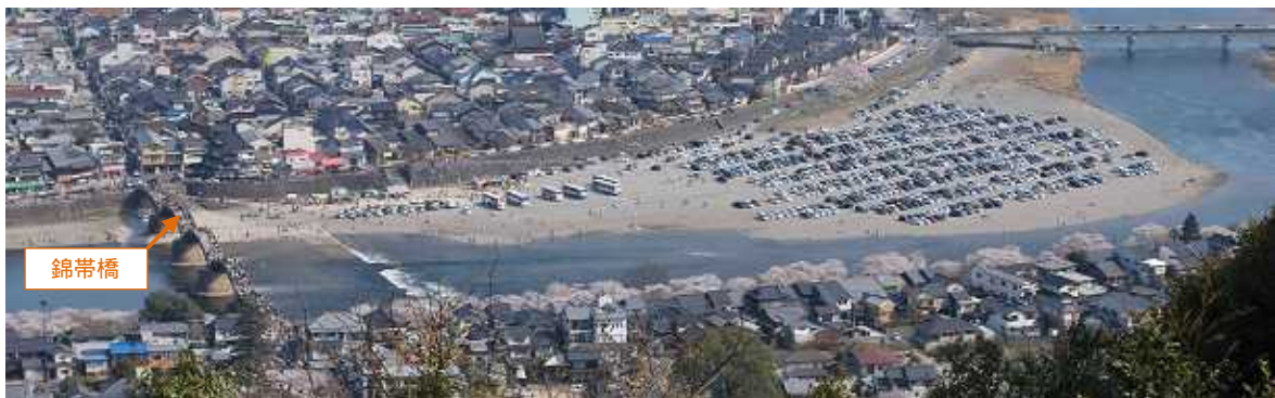
錦帯橋の下流に位置する錦帯橋下河原駐車場。河川敷の駐車場は河川景観の自然美の中で違和感を与える。
