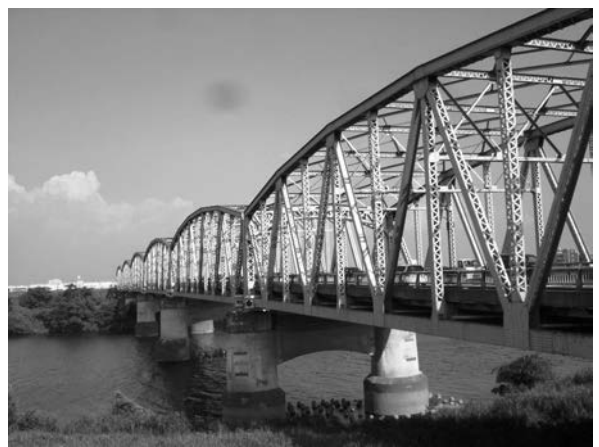
写真 1 長良大橋の概況
