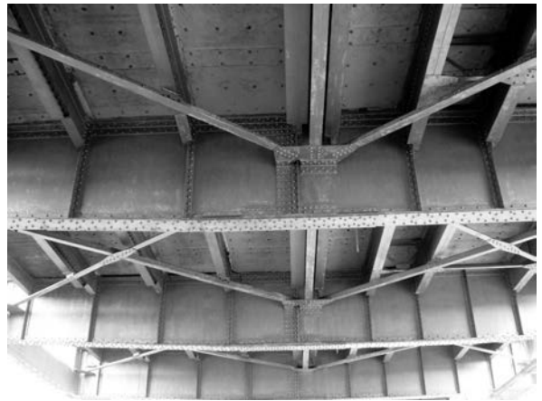
写真 2 桁下の状況（下流（右）側の桁高が高い）
